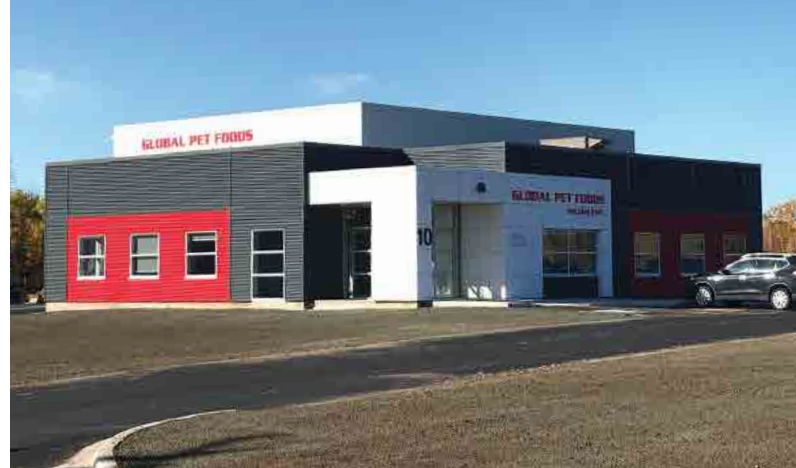
New Brunswick Global Pet Foods franchisee Jeff Kelly had this new 6,000 square foot office and warehouse constructed in the Moncton West Industrial Park. The building officially opened in September 2019. PHOTO: CONTRIBUTED / Jeff Kelly, franchisee de Global Pet Foods au Nouveau-Brunswick, a fait construire ce nouveau bureau/entrepôt de 6 000 pieds carrés dans le parc industriel de Moncton-Ouest. Le bâtiment a officiellement ouvert ses portes en septembre 2019. PHOTO: GRACIEUSETÉ
